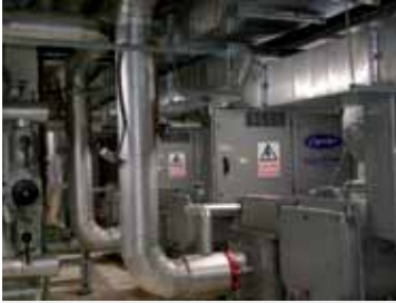
Türkiye'de ilk defa bu projede kullanılan yüksek cop değerine sahip frekans invertörlü vidalı kompresörlü su soğutmalı soğutma grupları.
