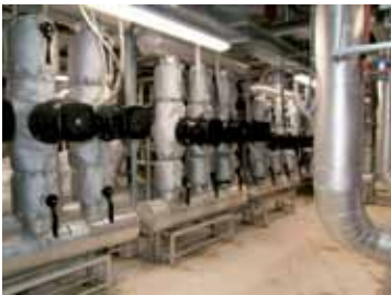
Tamamı frekans kontrollü soğutma zon pompaları. Yalıtıma özel önem verilerek, tüm vanalar vana ceketli ile kaplandı. Boruların izolasyon üzeri alüminyum sac ile kaplandı.
