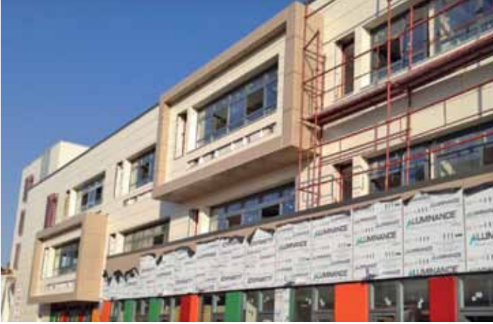
Okul Binası Giriş Cephesi – Sınıf, Pencere Altı Havalandırma Cihazı Menfezleri
