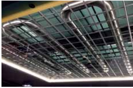
Şekil 5: Yapı İçinde Açıkta Bırakılan Döşeme Sistemi
