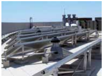
Kullanma sıcak suyu üretiminde kullanılan konvansiyonel güneş kolektörleri.
