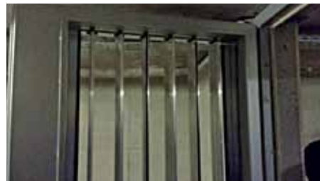
Şekil 8: Labirent İçindeki Otomatik Akım Damperleri
