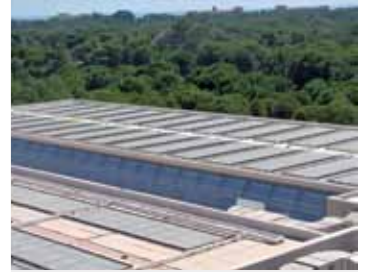
Açık havuzların ısıtmasına hizmet eden EPDM polikarbonat kılıflı yeni nesil, çatıya serilebilen formda güneş kolektörü sistemi.
