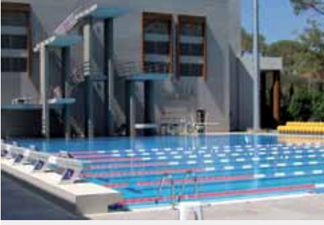
Atlama kuleleri ve açık havuz. Havuz suyu sıcaklığı yaz kış 26 °C de tutulmakta, yazın soğutulmakta kışın da ısıtılmaktadır.
