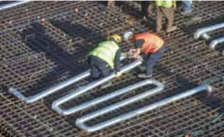
Şekil 4: Beton İçine Bırakılan Hava Kanalları
